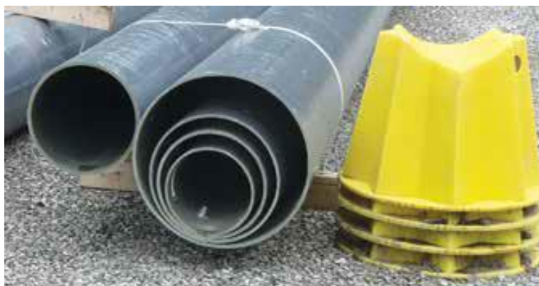
ب) استفاده از بلوک پلاستیکی
