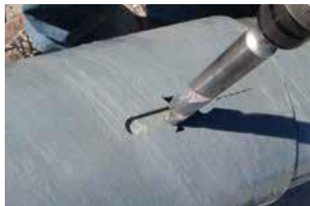
ب) دریل با استفاده از مته الماس
