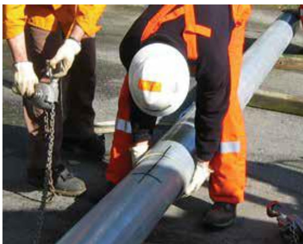
الف) استفاده از خطوط راهنما جهت هم‌راستا نمودن قطعات
