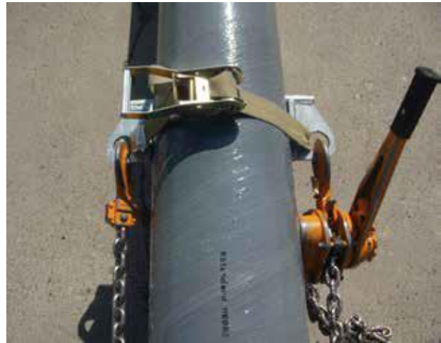
الف) استفاده از تسمه برزنتی
